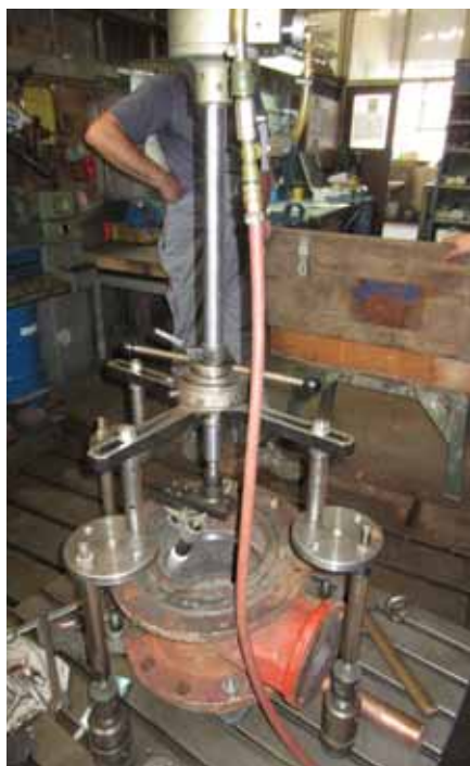
Visokoturažno brušenje sjedišta ventila
