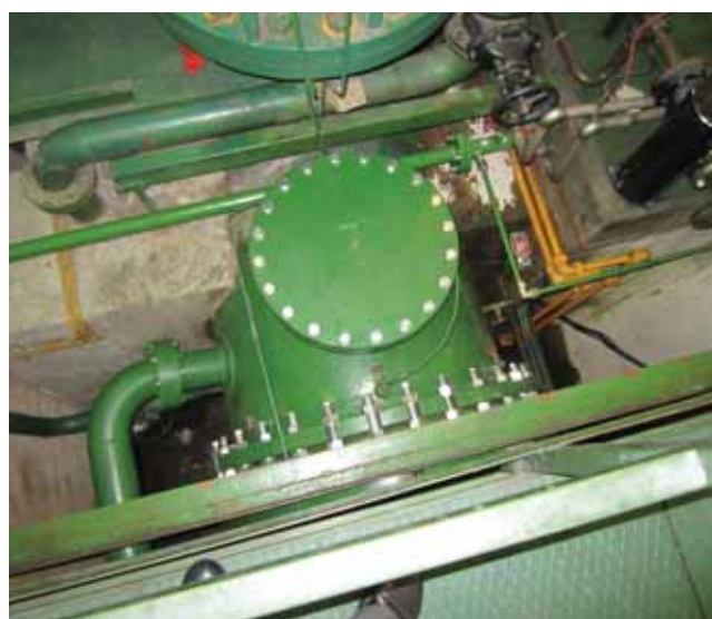
Hidroelektrana - servis leptirastog zatvarača
