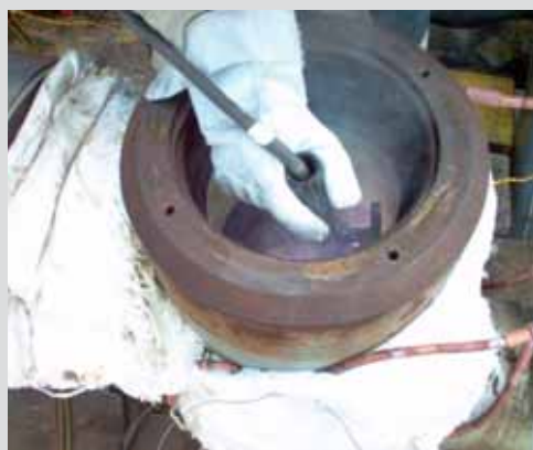
Termoelektrana - zamjena sjedišta regulacijskog ventila
