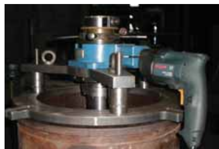
Tokarenje sjedišta ventila na dubini 1150 mm
